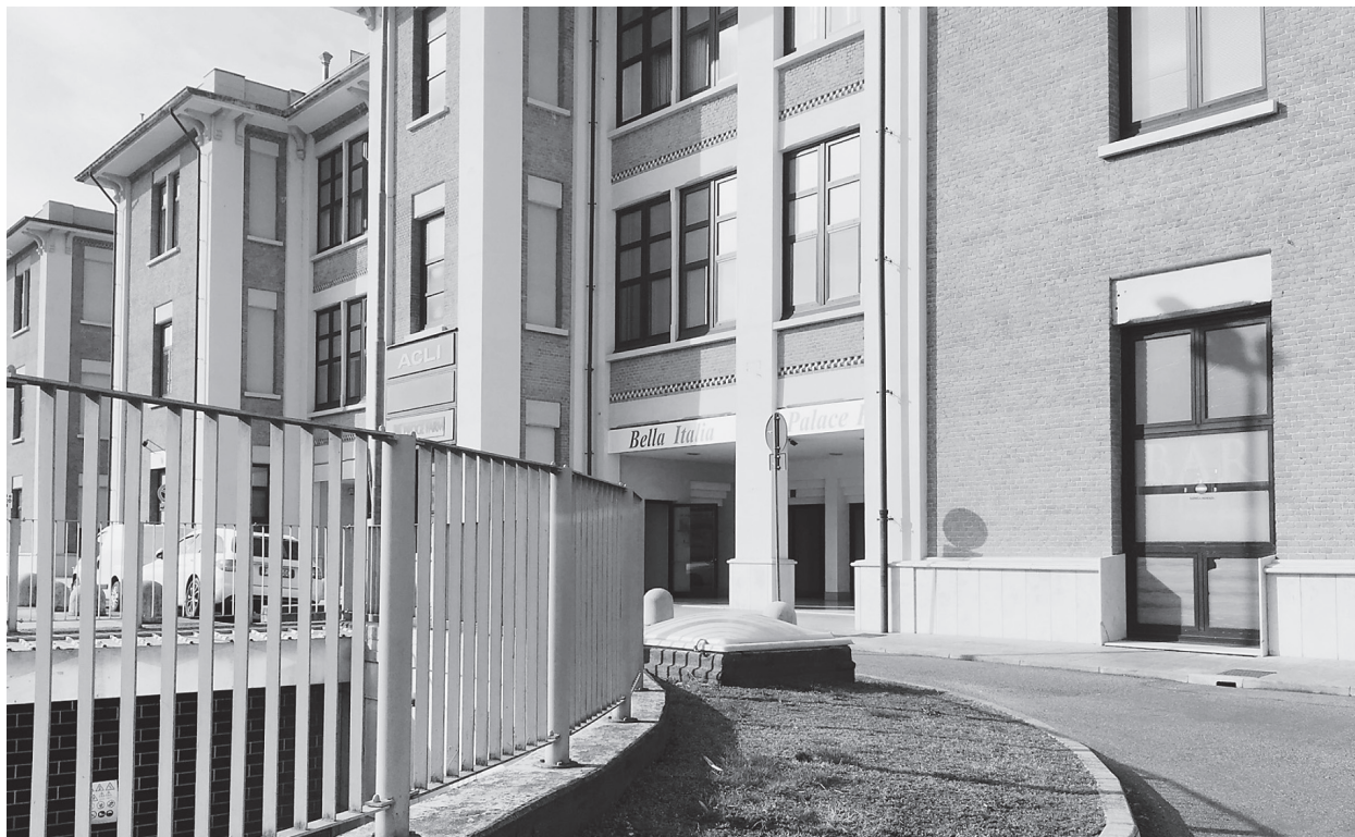
Fig. 5. Opera di riqualificazione dell'ex Cottonificio Wild, Dipartimento di Scienze del farmaco dell'Università del Piemonte Orientale Fonte: Fotografia di F.C., 2019
