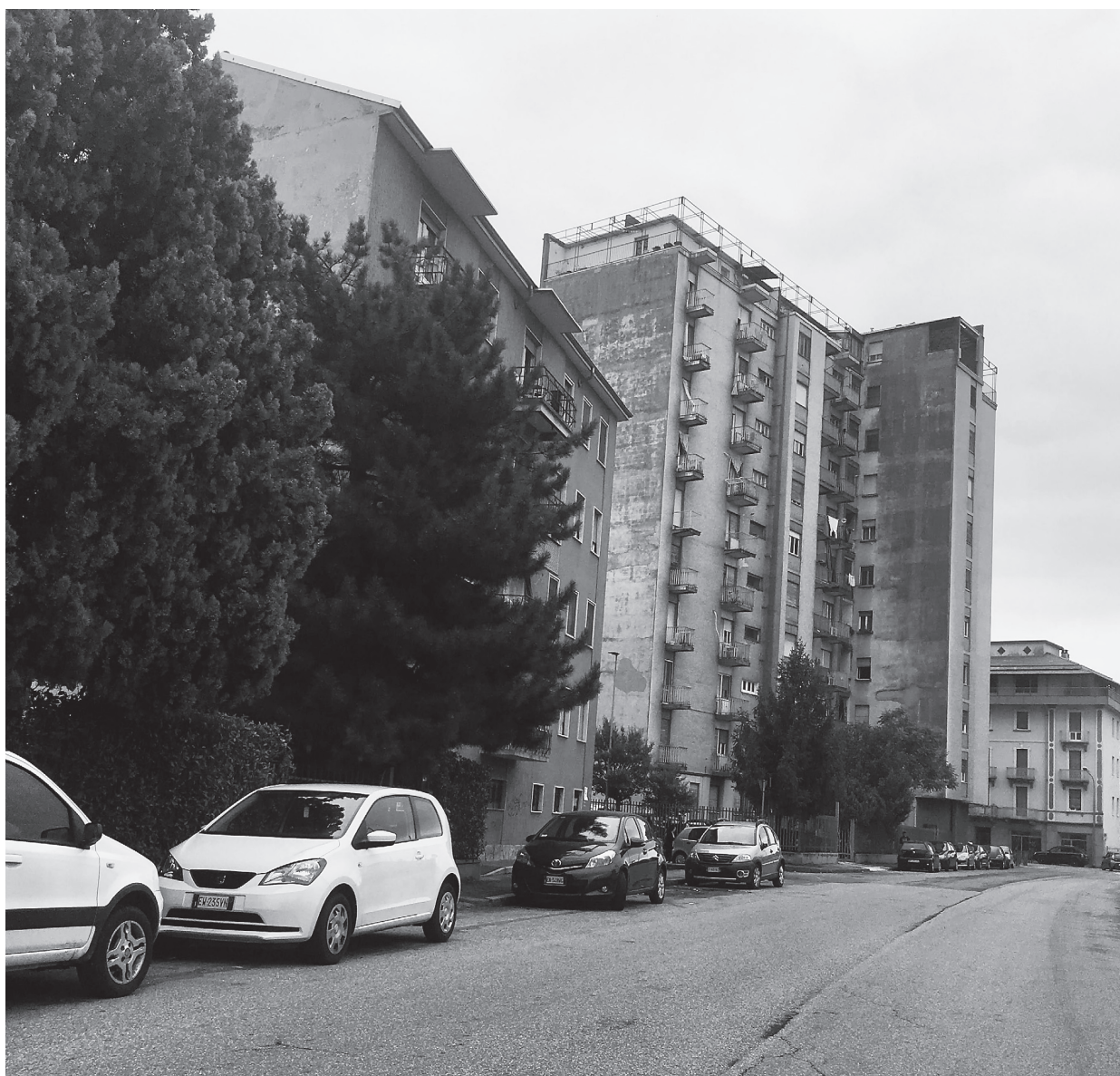
Fig. 2. Novara, quartiere di Sant'Agabio, immobili di Via Fogazzaro
