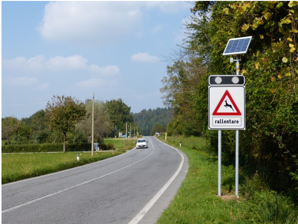
Figura 41 - Cartello luminoso ad alta visibilità installato sulla S.P. 211 (foto Davide Bonetto).
