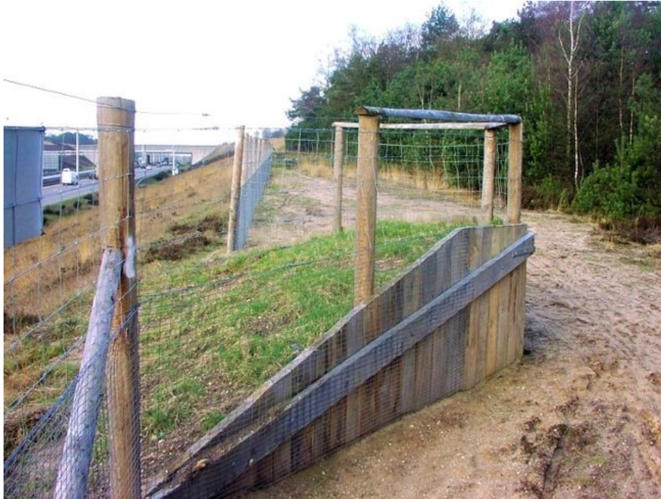
Figura 16 - Rampa di uscita dalla sede stradale per ungulati (foto tratta da http://www.pinchercreekecho.com ).
