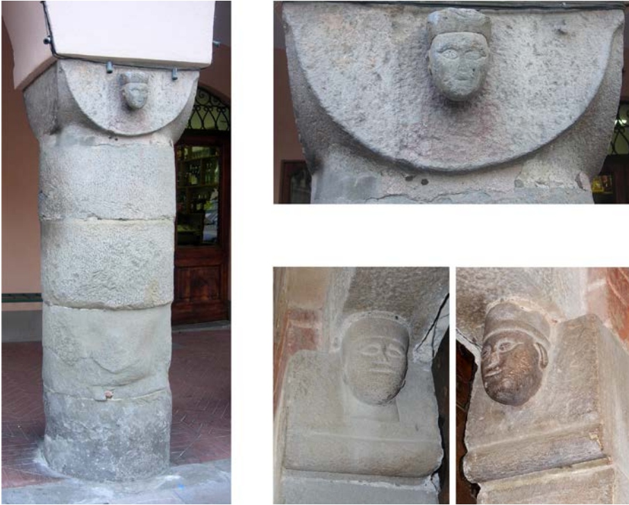
Fig. 11. Bobbio. A sinistra e a destra, in alto: Piazza della cattedrale, portici sul lato nord, colonna in rocchi lapidei e dettaglio del capitello; a destra in basso: mensole che inquadrano il portale di accesso all'edificio prospettante sul lato est del chiostro di San Colombano (foto E. Destefanis).
