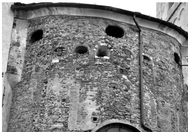
10. Ivrea, cattedrale. Parete absidale occidentale, con resti del coronamento a fornic.
