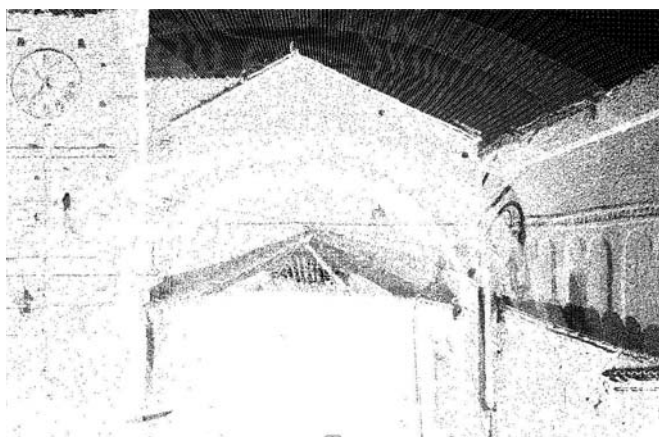
30. Balocco, San Michele. Rilievo laser-scanner, con veduta da nord-ovest. Sono percepibili i nessi tra profilo interno delle volte e pareti perimetrali.
