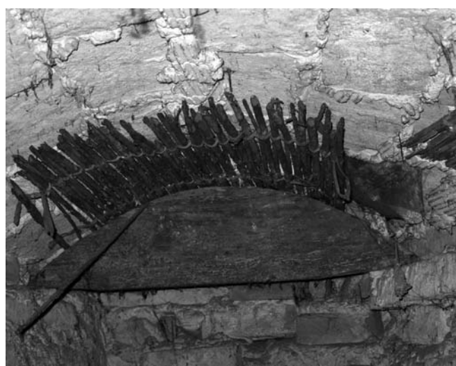
29. Modena, cattedrale. Resti del sistema di armatura "a perdere" delle volte di sostegno del pavimento del presbiterio.
