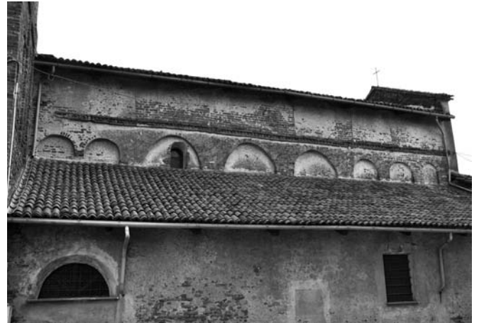
23. Balocco, San Michele. Veduta del lato nord.
