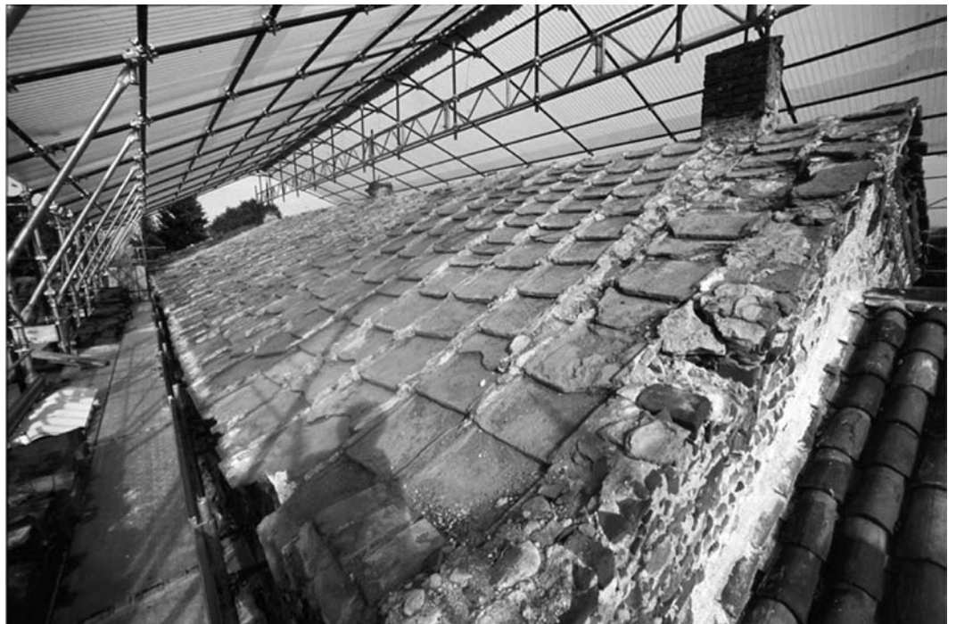
33. Pombia, San Vincenzo in Castro. Veduta dell'originario manto di copertura in tegoloni di reimpiego.
