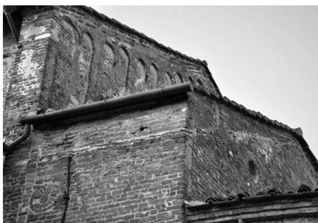
19. Lomello, Santa Maria Maggiore. Testata est, con tracce degli originari profili degli spioventi.
