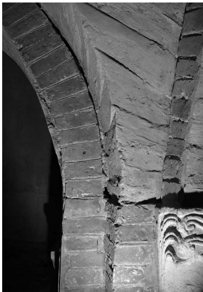
7. Ivrea, cattedrale. Cripta, settore orientale (XII sec.), particolare del sistema di armatura di una volta.
