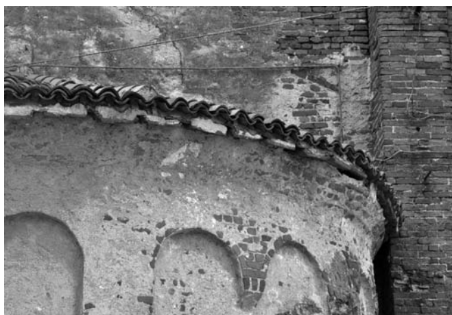
11. Balocco, San Michele. Abside, con resti dell'originario nesso tra parete, cornice di gronda "a sguscio" e copertura in tegoloni (situazione nel 2010, prima dello smantellamento dei tegoloni).
