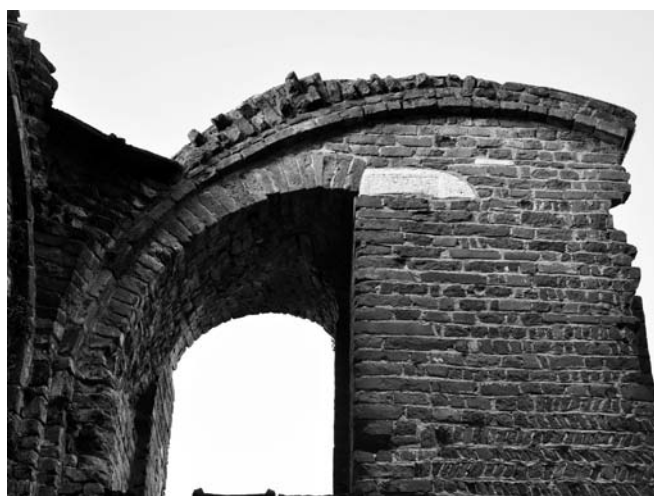
8. Lomello, Santa Maria Maggiore. Resti del perimetrale nord, con tracce del sistema di apparecchiatura della volta della navatella.
