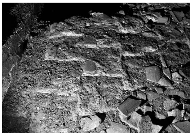
27. Balocco, San Michele. Sottotetto, con tracce della originaria copertura in tegoloni di reimpiego.
