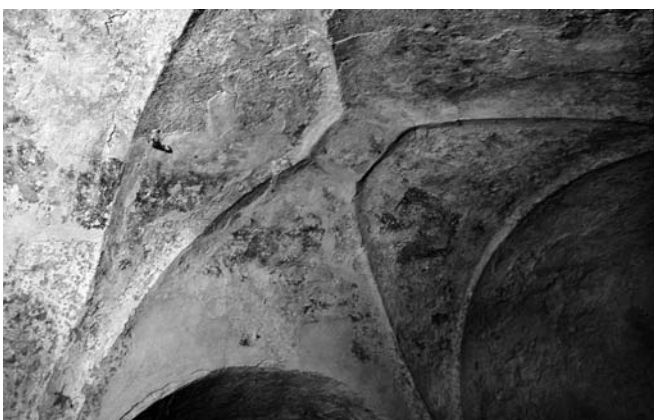
3. Pavia, San Felice. Cripta, particolare di una volta a crociera.
