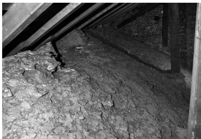
18. Susa, cattedrale. Sottotetti, estradosso a spioventi della volta a botte del transetto sud.
