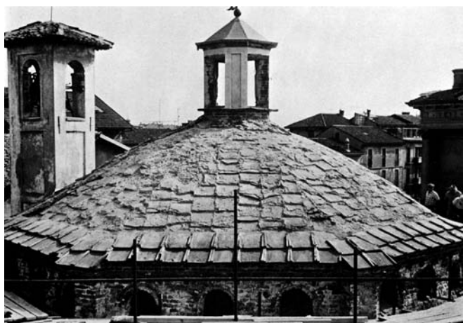
13. Novara, battistero. Estradosso della volta a padiglione con tracce della originaria copertura in tegoloni di riempiego (da CHERICI 1967).
