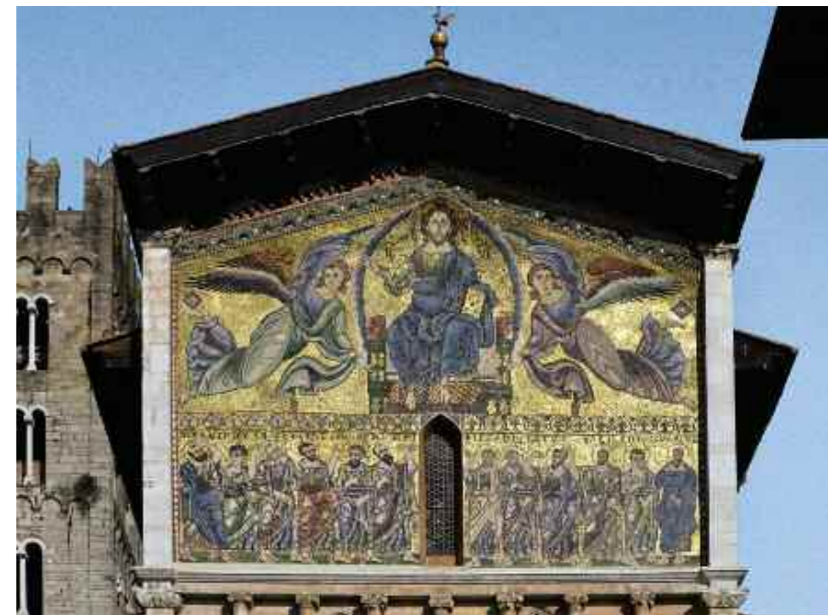
6. Lucca, San Frediano, particolare della parte alta della facciata
