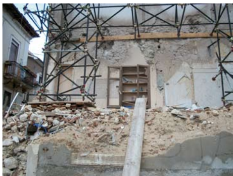
Fig. 3. L'Aquila. Resti di un'abitazione nella zona rossa (Foto: R. Afferni).
