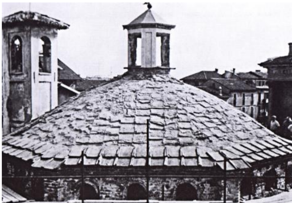
Fig. 3 Novare, baptistère de la cathédrale. Couverture en tegulae mise en évidence pendant les travaux de restauration des années soixante.
