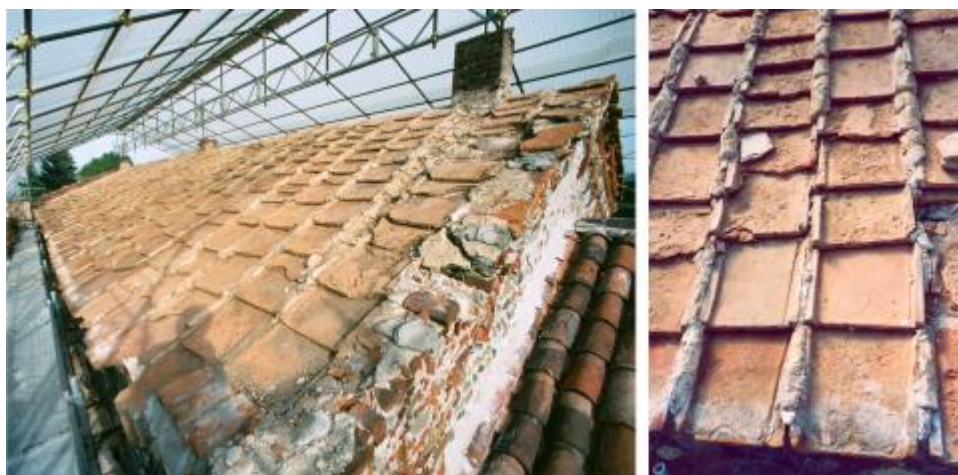
Fig. 8 Pombia, Saint-Vincent in castro . À gauche : fouille de la toiture en tegulae de réemploi découverte lors des travaux de restauration de 2001 ; à droite : détail des tuiles, dont certaines avec des marques réalisées avant cuisson.
