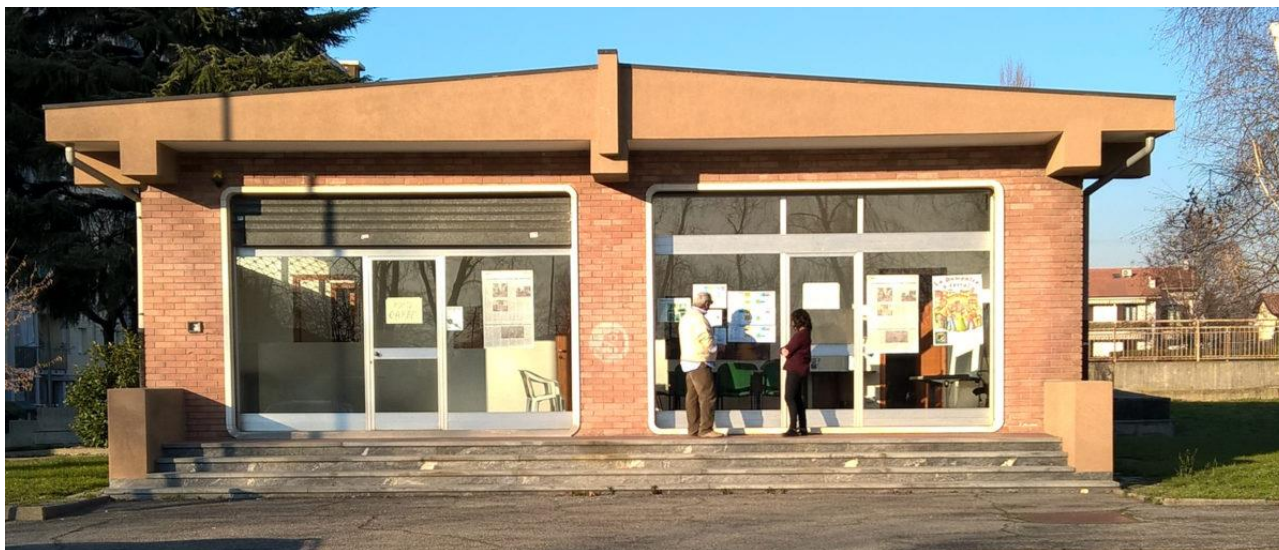
La struttura del centro polifunzionale di piazza Donatello (dopo i primi lavori di ristrutturazione, prima della installazione della rampa di accesso per portatori di handicap)
