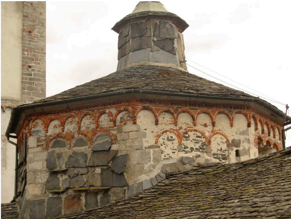
Fig. 12 Orta, Saint-Jules. Dalles en pierre remployées et plaquées contre les murs de la tour de croisée.
