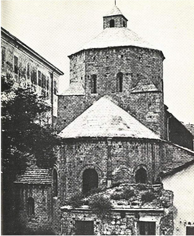
Fig. 13 Vintimille, cathédrale Sainte-Marie. Couvertures en dalles de pierre de l'abside et du dôme, découvertes lors des restaurations des années 1940.
