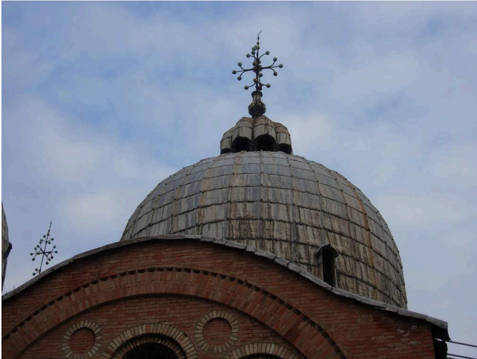
Fig. 11 Venise, Saint-Marc. Détail de la couverture en tuiles en plomb sur l'une des « coupoles » de la cathédrale.
