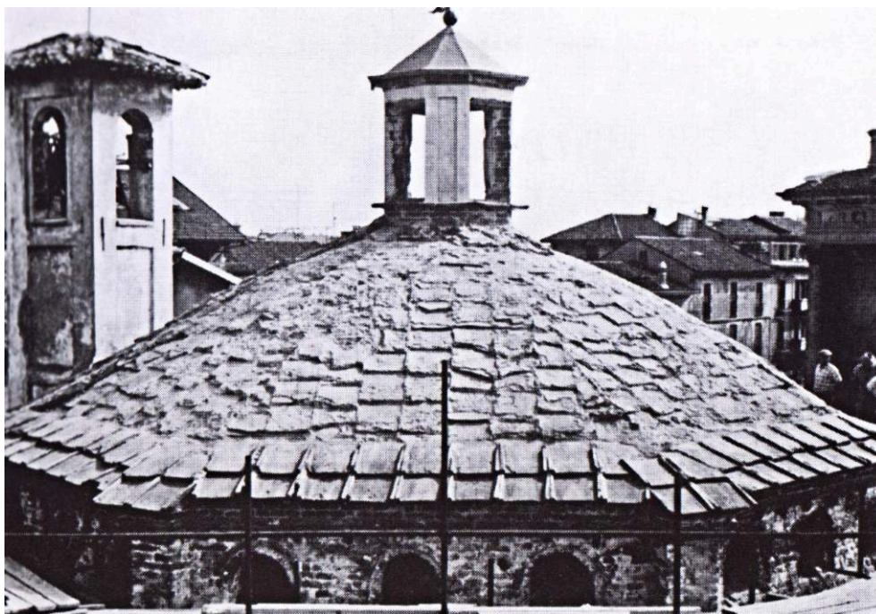
Fig. 3 Novare, baptistère de la cathédrale. Couverture en tegulae mise en évidence pendant les travaux de restauration des années soixante.
