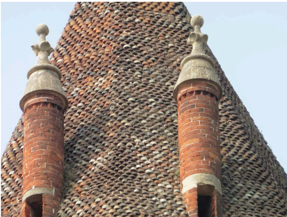
Fig. 10 Vercelli. Saint-André. Briques « en sabot de cheval » constituant la flèche sur la tour octogonale à la croisée du transept.
