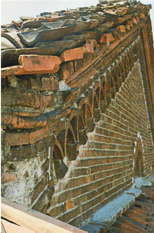
Fig. 2 Monza, « Duomo » Saint-Jean Baptiste. Tegulae de type romain encore en place au sommet de l'édifice, sous la couverture en tuiles canal.
