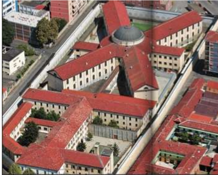
Figura 1. Il carcere di Alessandria, struttura a disposizione radiale - vista dall'alto
